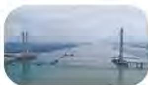
赤壁长江大桥为主跨720米的双塔双索面结合梁斜拉桥，主梁采用混凝土板和钢主梁上下结合的布置。结合梁斜拉桥受力复杂，设计与施工难度较大，此前世界上已建成的该类型斜拉桥的主跨不超过660米，而赤壁长江大桥一举突破了700米的大关。
